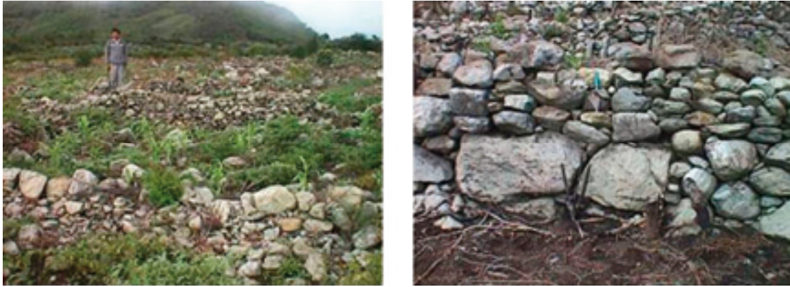
Fig. 5.17. A la izquierda: Huertos amurallados. A la derecha: Detalle de muro de un huerto en el que puede observarse la tecnología de construcción (Fotos: Walter Sánchez C.).
